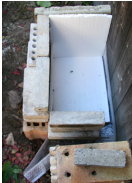
Styropor als Isolation
