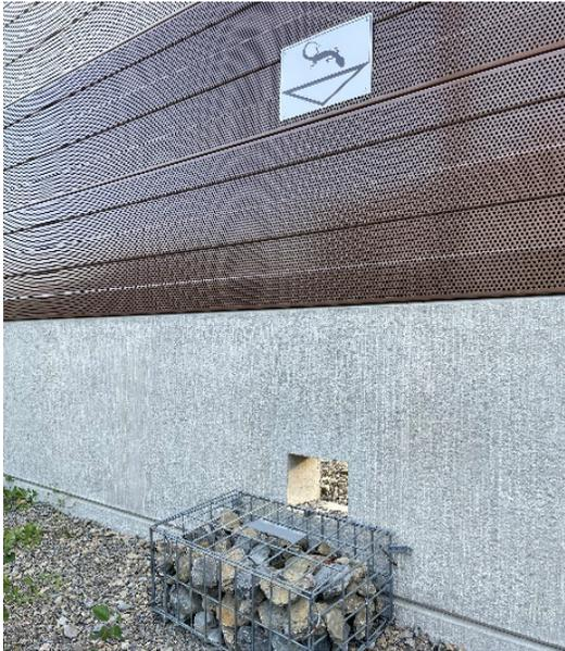
Bild 19: Funktionale Durchlässe bei der Deutschen Bahn: bei Lärmschutzbauten inzwischen bundesweiter Standard.
